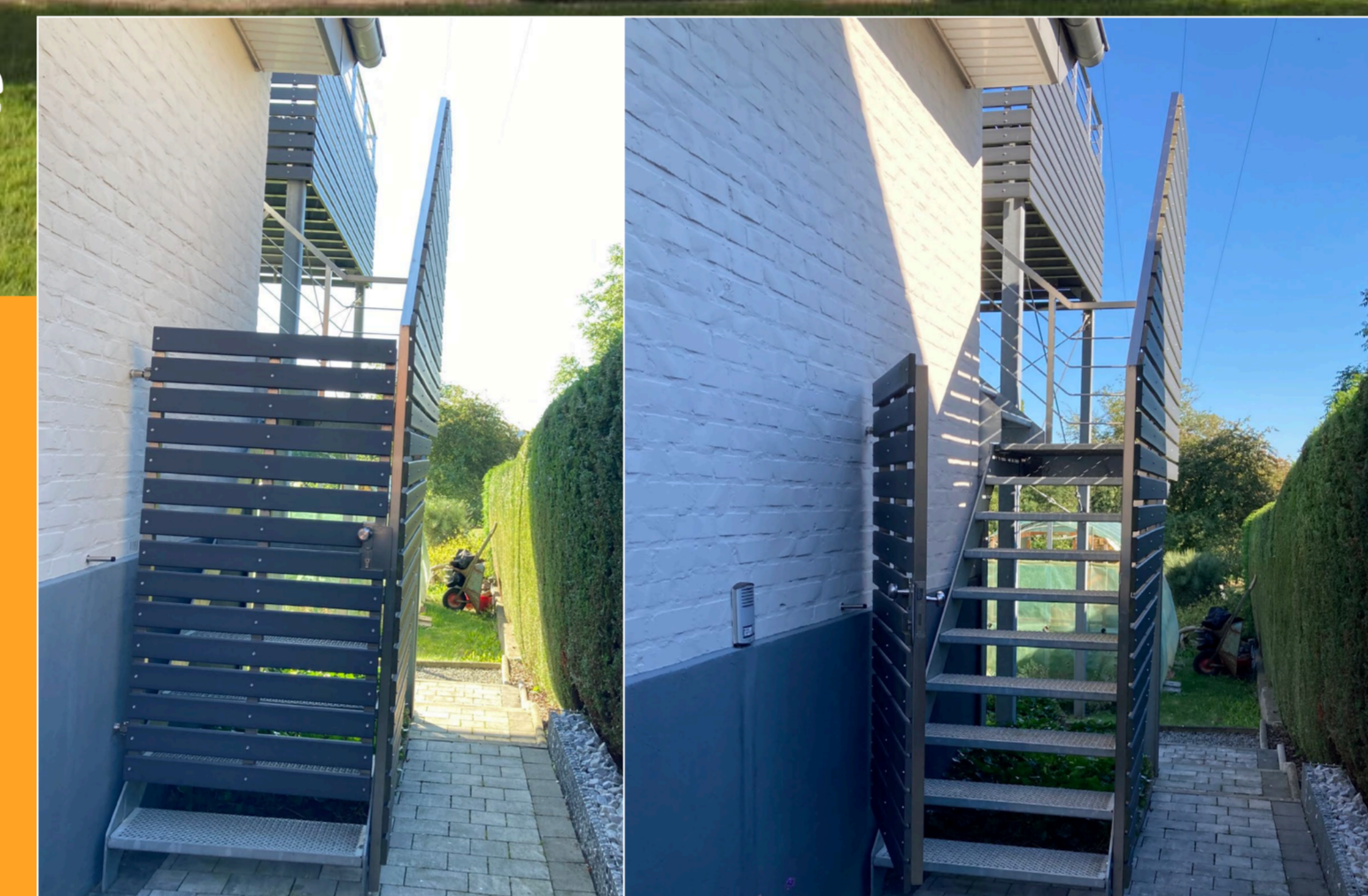
Zugang Wohnung Dachgeschoss
